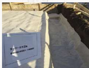
2 土木シートを敷きます。
