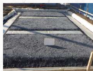
8 隙間を碎石で 埋め戻し、設置完了。
