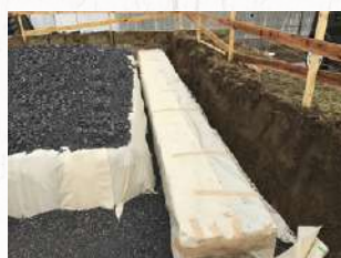
6 スーパージオ®材を 土木シートで梱包します。
