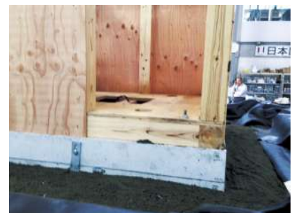
スーパージオ®SG300では液状化なし、建物の傾きなし、液状化による噴砂なし
