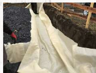
4 再び土木シートを 敷きます。
