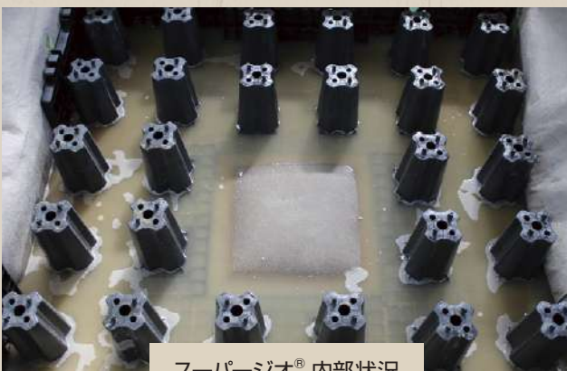
スーパージオ® 内部状況
