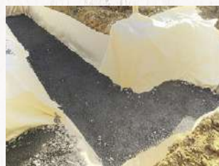
3 碎石を敷き 転圧を行います。
