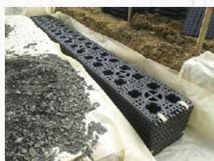
5 スーパージオ®材を 設置します。
